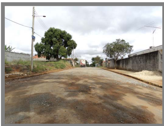
Foto 34 Rua Sem Nome – Área sem rede de esgoto.
