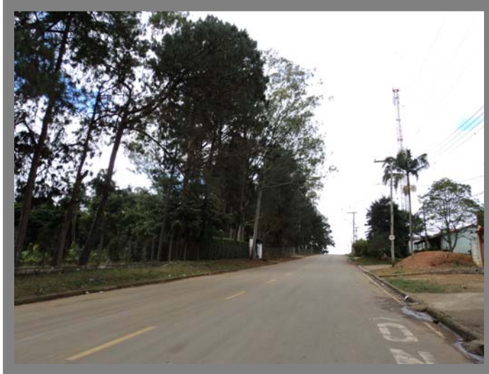
Foto 32 Rua Nishio Tadashi – Área sem rede de esgoto.
