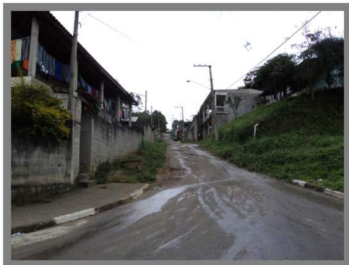
Foto 24 Rua Sem Nome – Área sem rede de esgoto.
