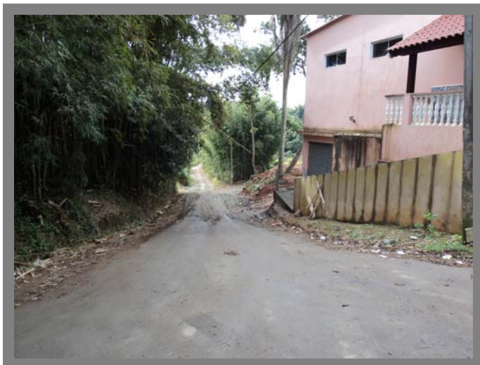
Foto 26 Rua Sem Nome – Área sem rede de esgoto.
