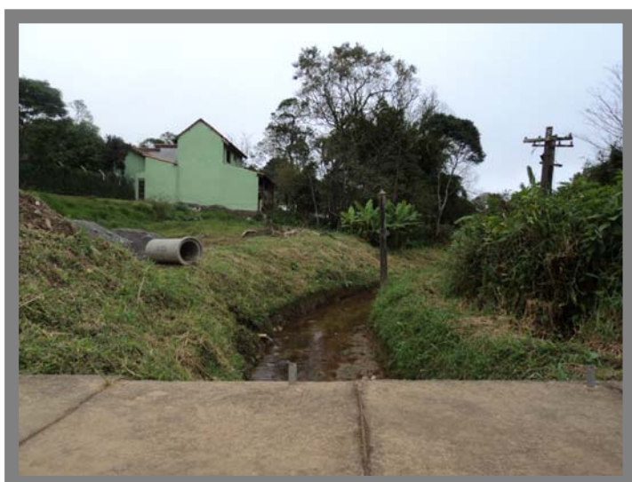
Foto 49 Córrego com lançamentos de esgoto “in natura” – Área sem coleta de esgoto.
