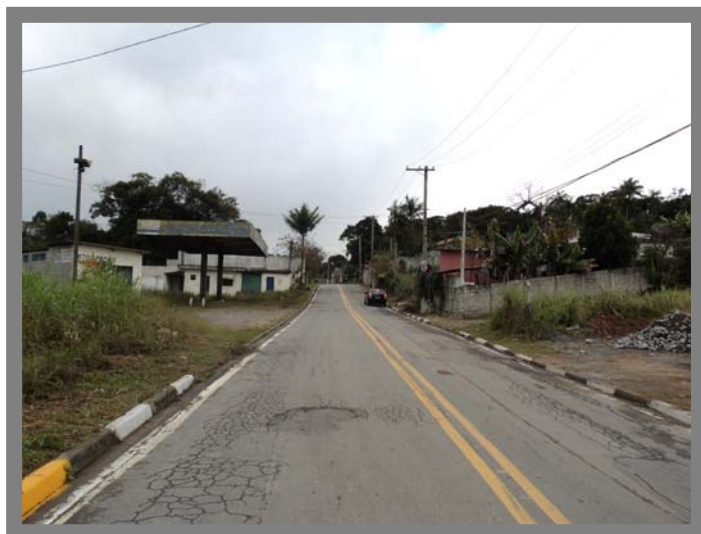
Foto 23 Rua Cruzeiro – Área sem rede de esgoto.
