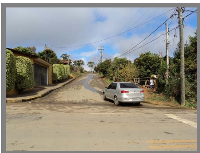
Foto 28 Rua Sem Nome – Área sem rede de esgoto.
