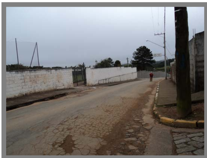
Foto 48 Rua Sem Nome – Área sem coleta de esgoto.
