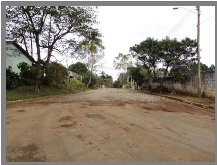
Foto 33 Rua Sem Nome – Área sem rede de esgoto.
