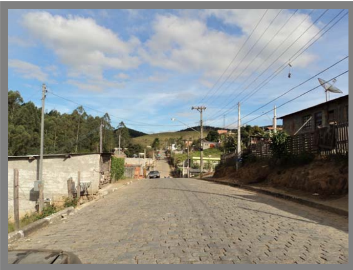
Foto 42 Rua Sem Nome – Área sem esgoto.
