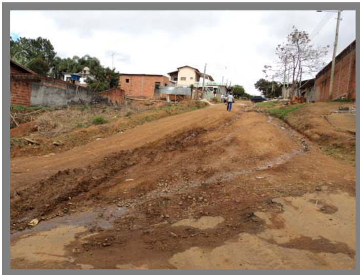
Foto 36 Rua Sem Nome – Área sem rede de esgoto.
