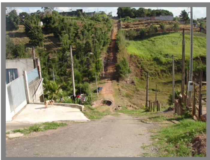
Foto 6 Rua Santos – Área sem rede de esgoto.
