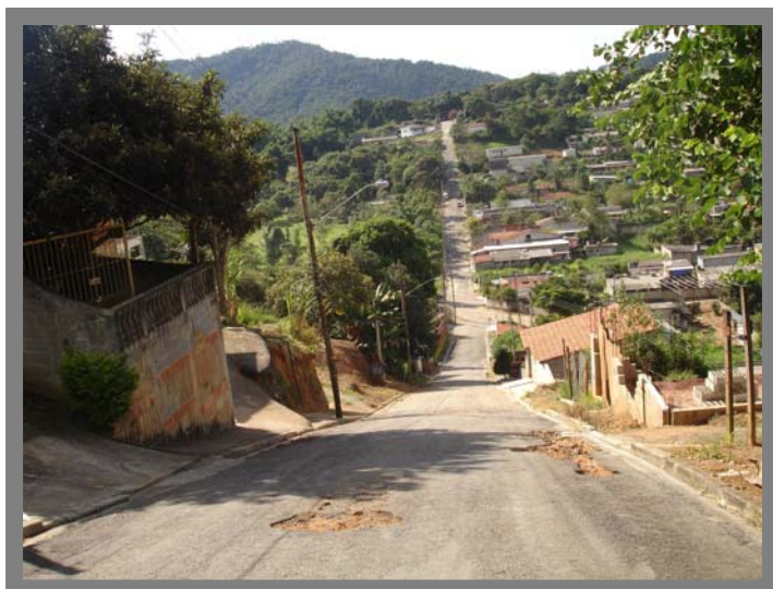
Foto 2 Rua Independência – área sem rede de esgoto
