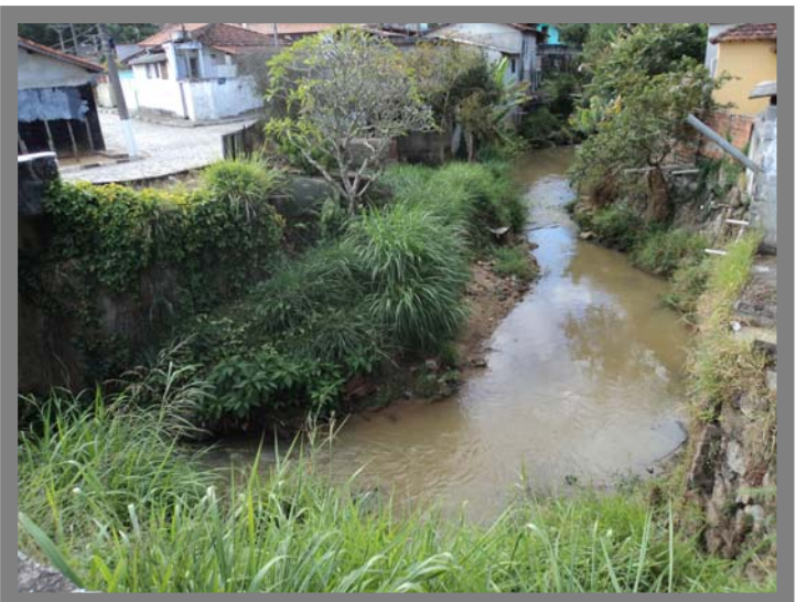
Foto 43 Córrego com lançamento “in natura”.
