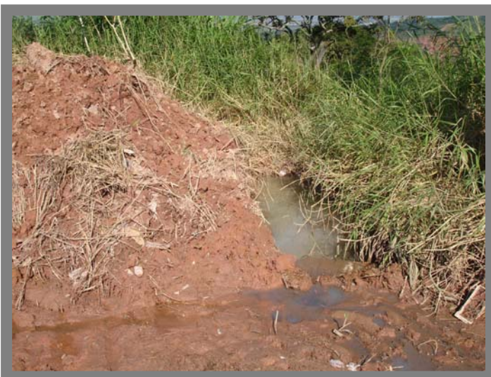
Foto 9 Rua Cora Coralina – Esgoto a céu aberto
