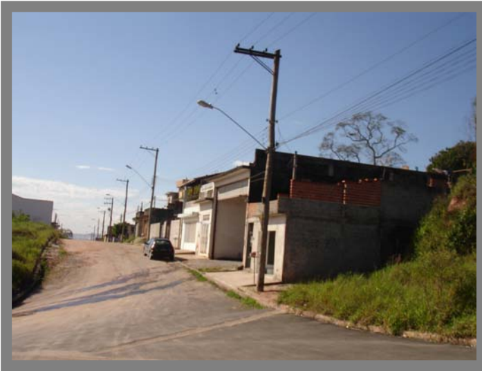
Foto 7 Rua Augusto dos Anjos – Área sem rede de esgoto.
