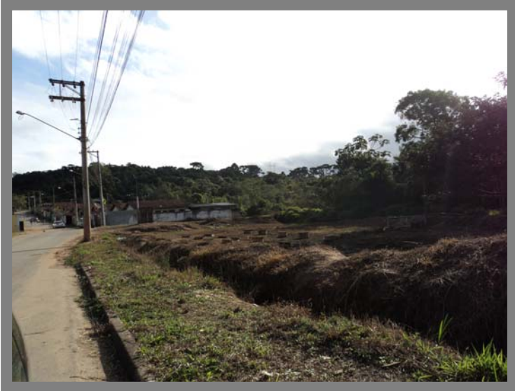
Foto 13 Sistema de tratamento de esgoto – Fossa Filtro.
