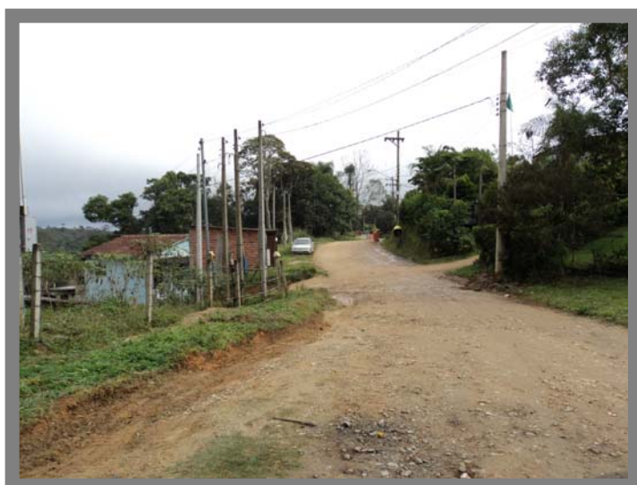
Foto 25 Rua Seis de Junho – Área sem rede de esgoto.
