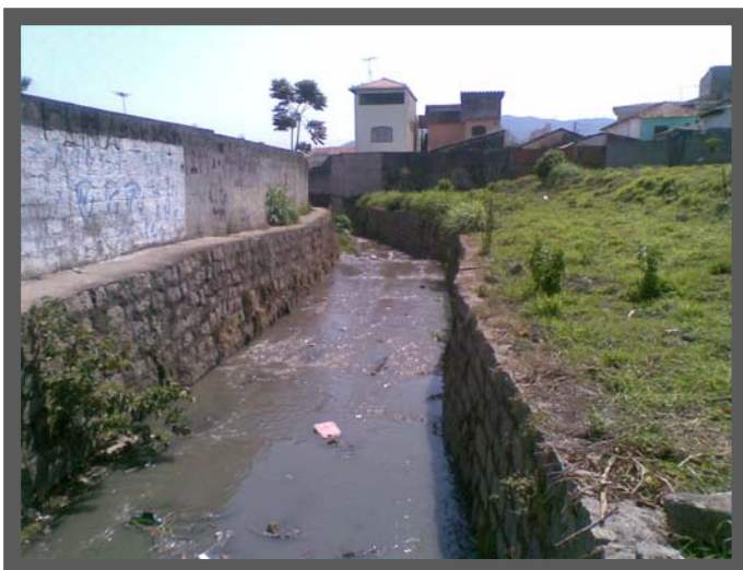
Foto 17 Ribeirão Negro – Canalizado e com lançamento de esgotos “in natura”.
