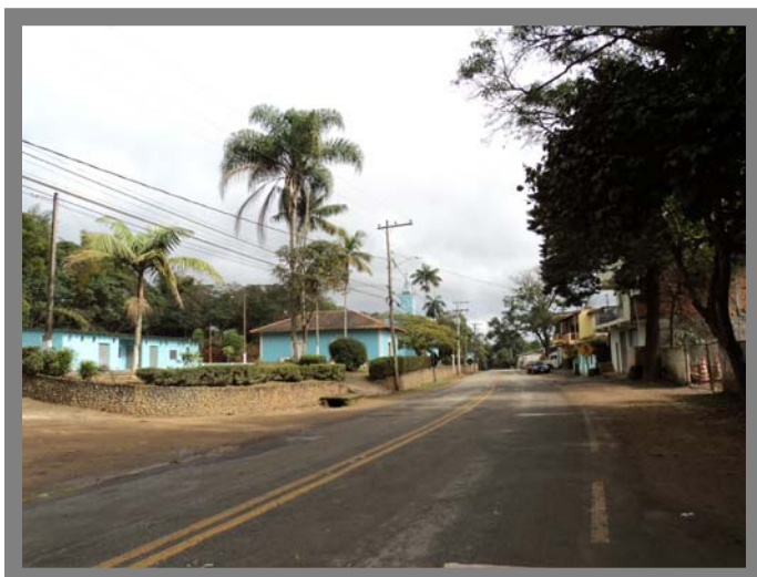
Foto 27 Rodovia Eng° Cândido do Rego Chaves – Área sem rede de esgoto – Centro de Barroso.
