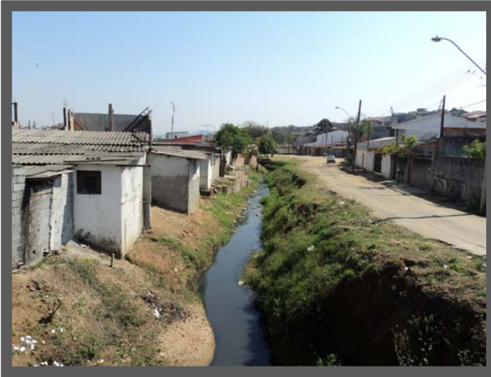
Foto 21 Ribeirão Canudos – Lançamento de esgotos “in natura”.
