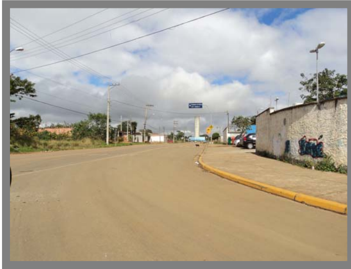
Foto 38 Avenida Principal – Área sem rede de esgoto.
