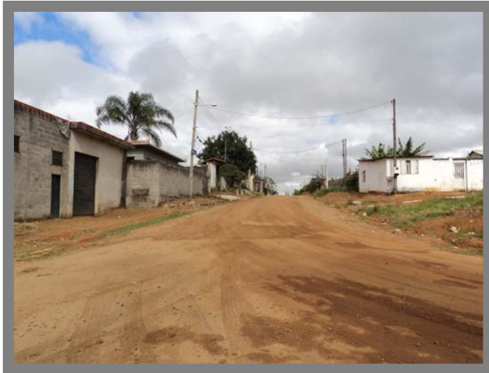
Foto 35 Rua Sem Nome – Área sem rede de esgoto.
