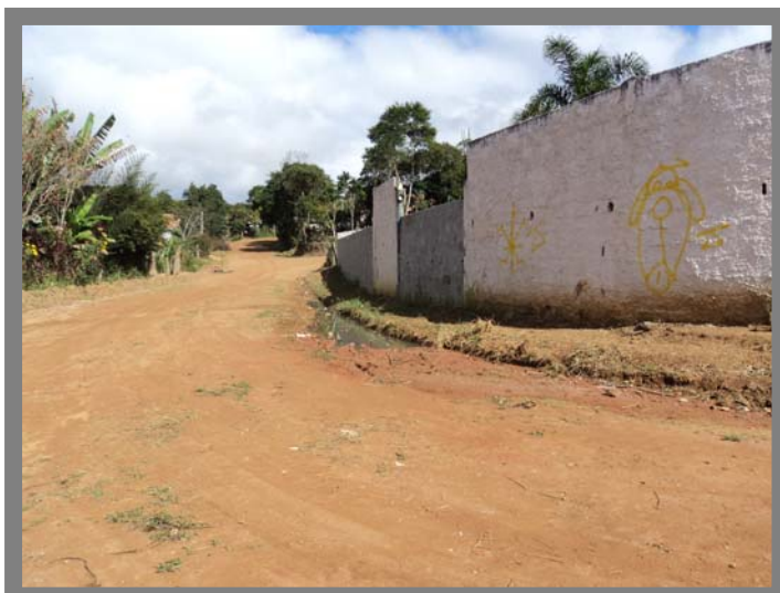
Foto 40 Rua Sem Nome – Área sem rede de esgoto.
