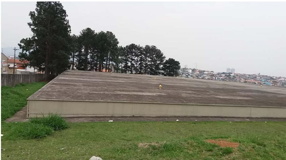
**Figura 4.1. Reservatório Apoiado do Centro de Reservação RB2**
