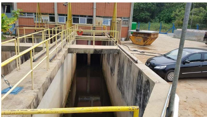
**Foto 8: Canal de entrada para o poço de sucção e casa de bombas ao fundo**
