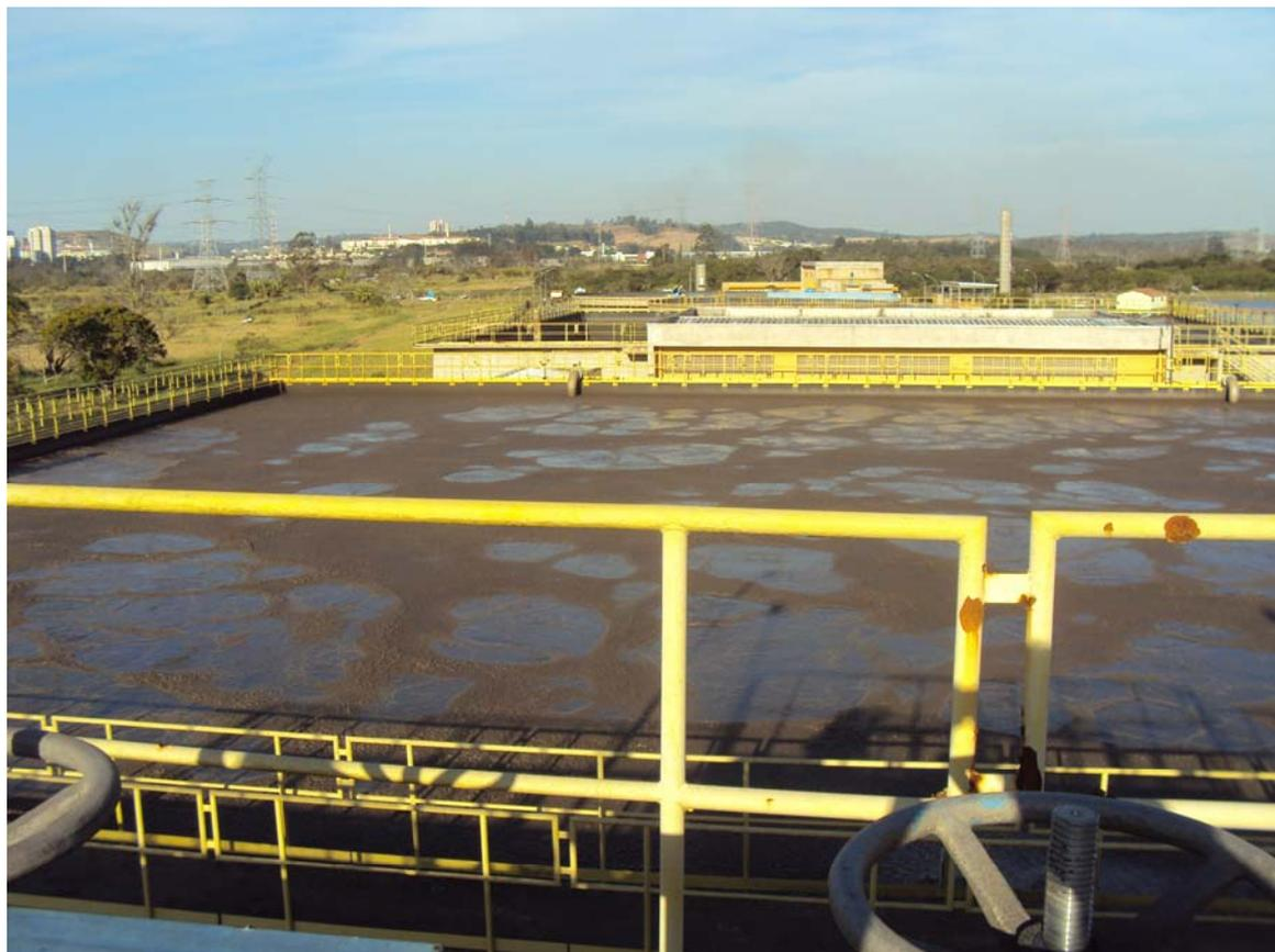
**Foto 13. Foto de um dos Tanques de Aeração. O outro Tanque se encontra mais ao fundo e entre eles a Casa de Sopradores**
