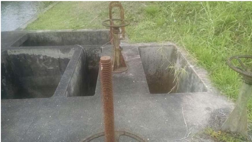
Foto 2: Vista parcial da caixa de entrada de água bruta – ECR I e pedestais de manobra das comportas.
