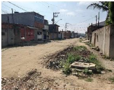
Falta de infraestrutura
