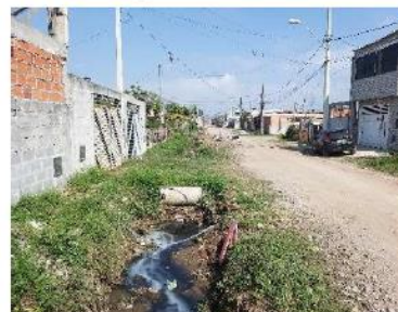
Falta de infraestrutura
