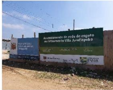
Placa de obra - redes de esgoto
