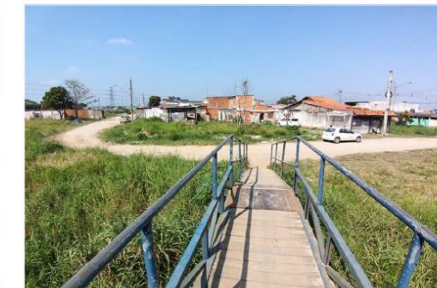
Passarela metálica sobre o Rio Jundiá - Área de Risco
