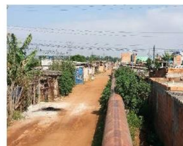
Adutora de Água Sabesp
