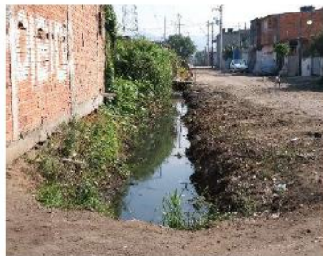
Lançamento em vala de Esgoto
