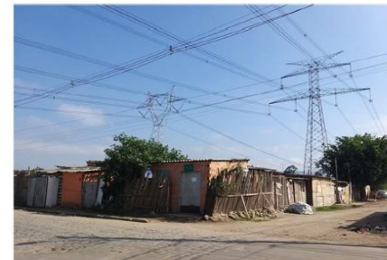
Habitções sob a Faixa de Alta Tensão CTEEP
