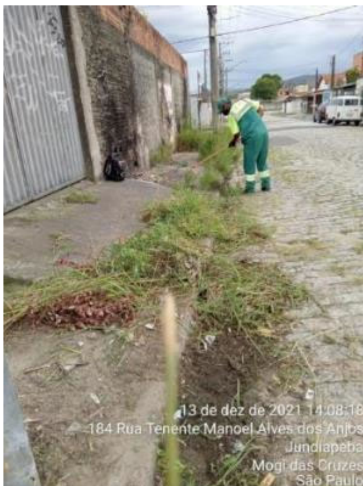
Figura 14 - Serviço de raspagem
